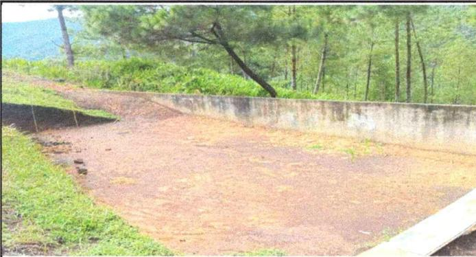
Foto 1: Vista adentro del muro del establecimiento, donde se refleja el mal estado en que se encuentra el muro.
