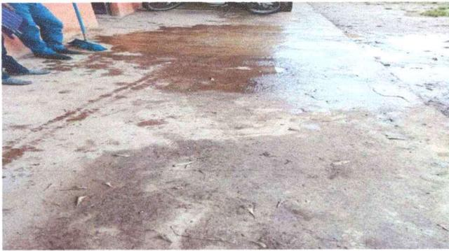
Foto 1: Sustituir el entortado.
