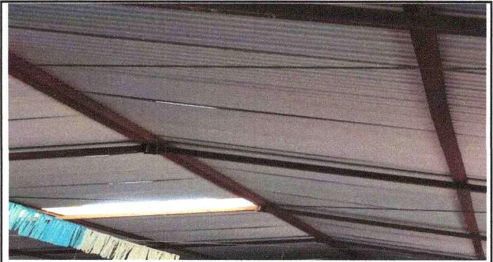
Foto 2: Se observa claramente la necesidad de sustituir el techo de la escuela ya que se encuentra en mal estado.
