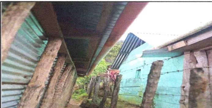
Foto 5: En la parte de atrás necesita poner canales para que no se siga destruyendo la parte de atrás de la escuela.
